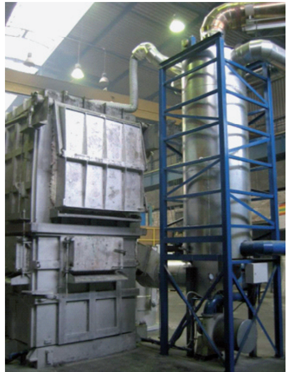
Rekuperator dla pieca o mocy palników 1600kW
